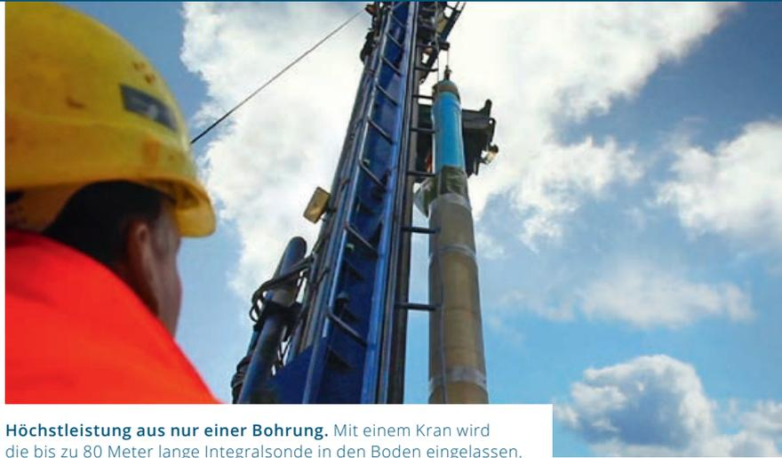
**Höchstleistung aus nur einer Bohrung.** Mit einem Kran wird die bis zu 80 Meter lange Integralsonde in den Boden eingelassen.
