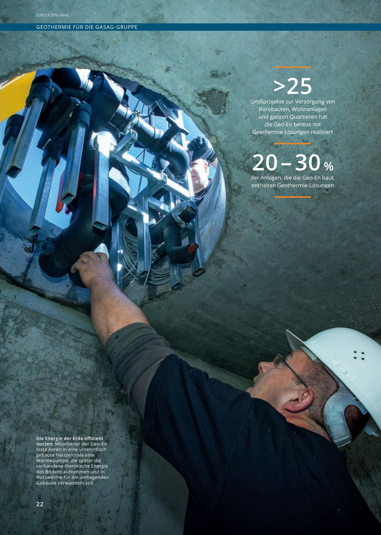
**Die Energie der Erde effizient nutzen:** Mitarbeiter der Geo-En installieren in eine unterirdisch gebaute Heizzentrale eine Wärmepumpe, die später die vorhandene thermische Energie des Bodens aufnehmen und in Nutzwärme für die umliegenden Gebäude verwandeln soll.
